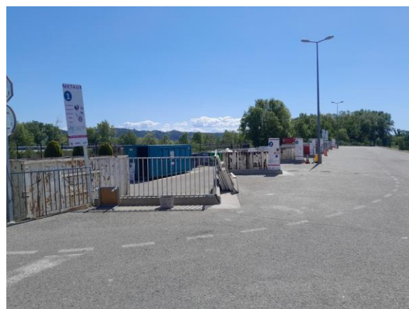
Déchèterie Villeneuve – Garde coprs fixes
