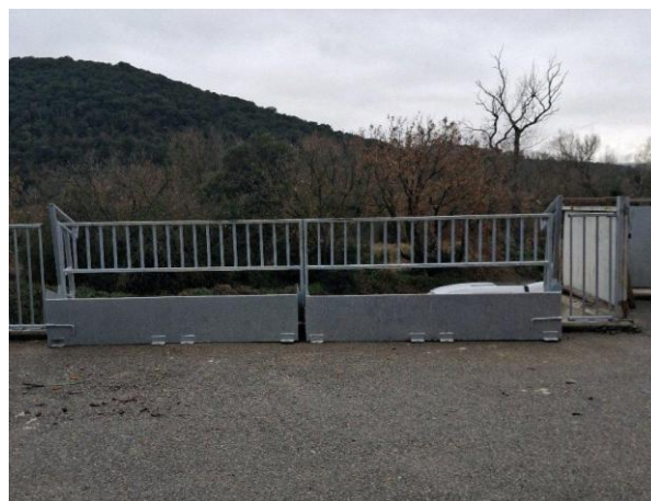
Déchèterie Gréoux les Bains – Trémies à gravats
