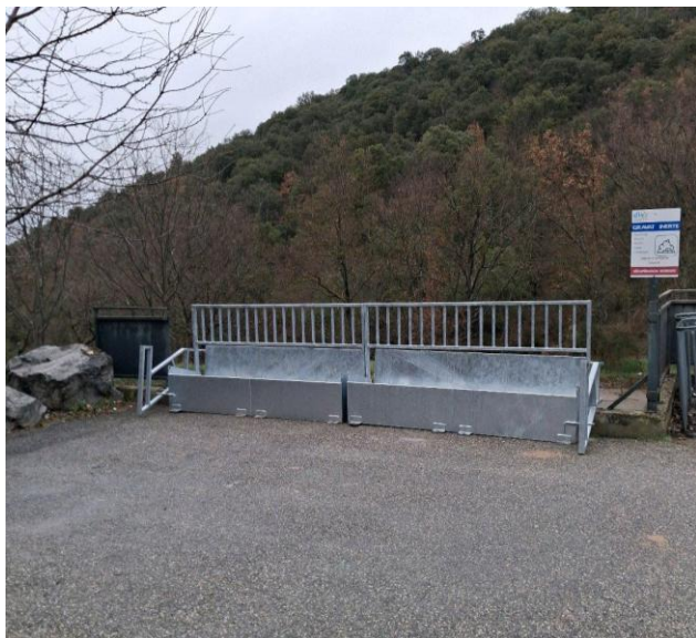
Déchèterie Le Castellet – Trémies à gravats
