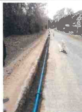
Chantier d'interconnexion entre Oraison et le Castellet (2023)
