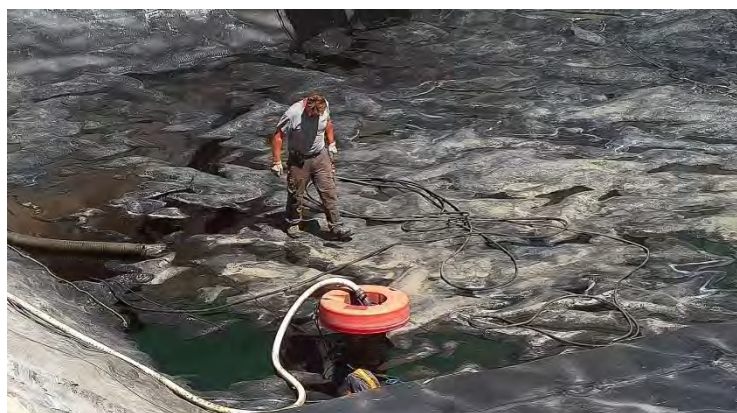
Inspection après nettoyage
