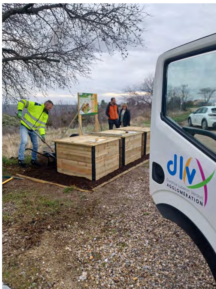
Installation composteurs partagés de Puimoisson
