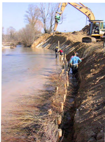
Restauration de berge en génie végétal © PNRL
