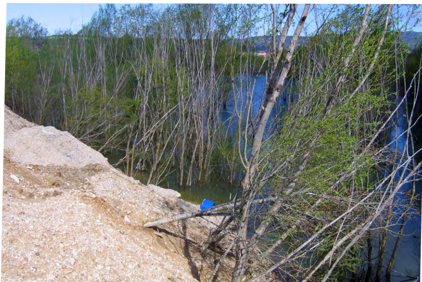
Remblaiement d'une mare ©PNRL
