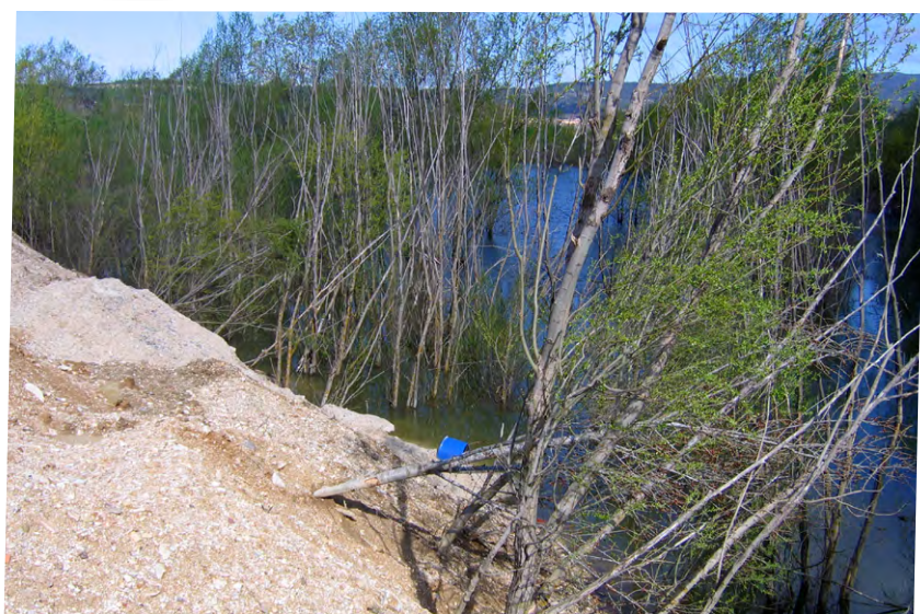
Remblaiement d'une mare ©PNRL
