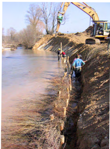
Restauration de berge en génie végétal © PNRL
