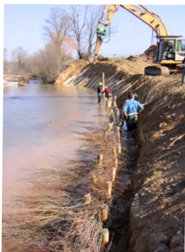
Restauration de berge en génie végétal © PNRL
