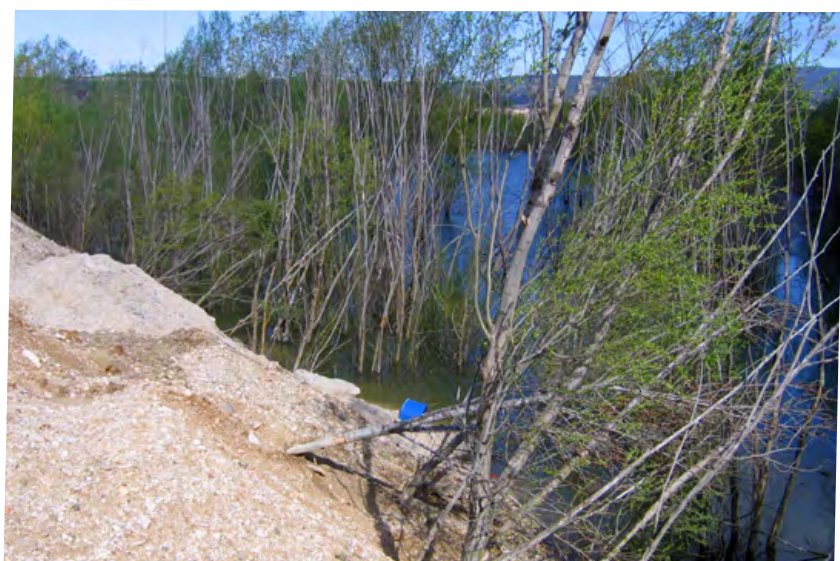
Remblaiement d'une mare ©PNRL
