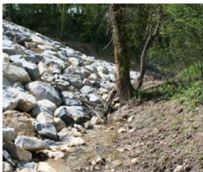
Enrochement de berge et de lit de rivière
