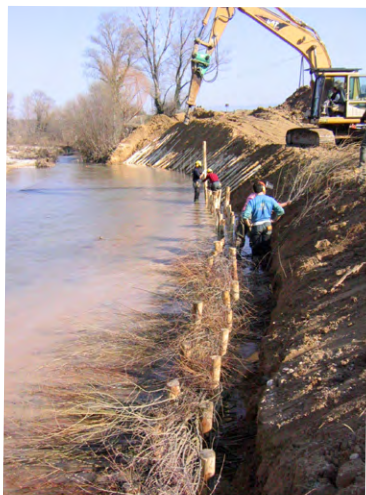
Restauration de berge en génie végétal © PNRL
