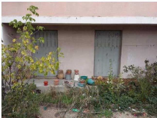
Pieds d'immeuble résidence les Plantiers
