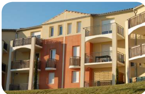
Logement collectif des années 2000
